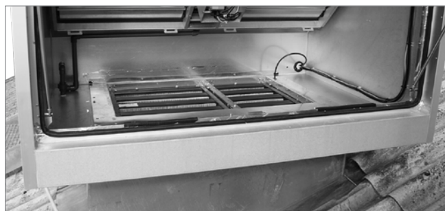
Obr. 34: Filtr odsávaného vzduchu instalovaný v jednotce
